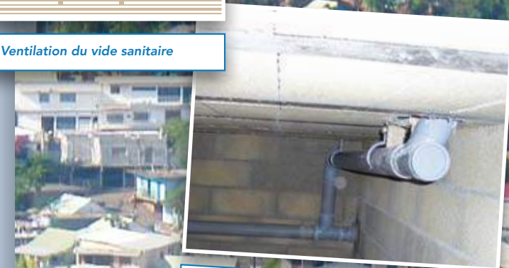
Vide sanitaire avec tuyaux d'évacuation des eaux usées
