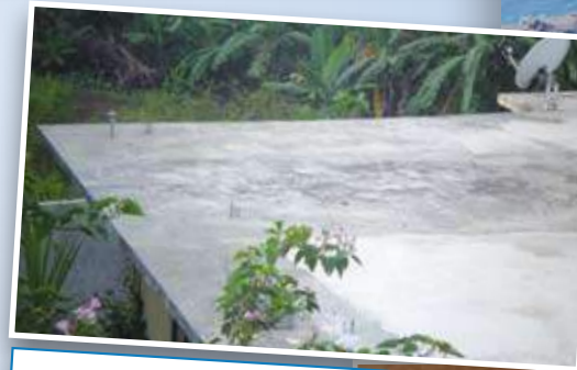
Etage en attente : toiture terrasse non protégée
